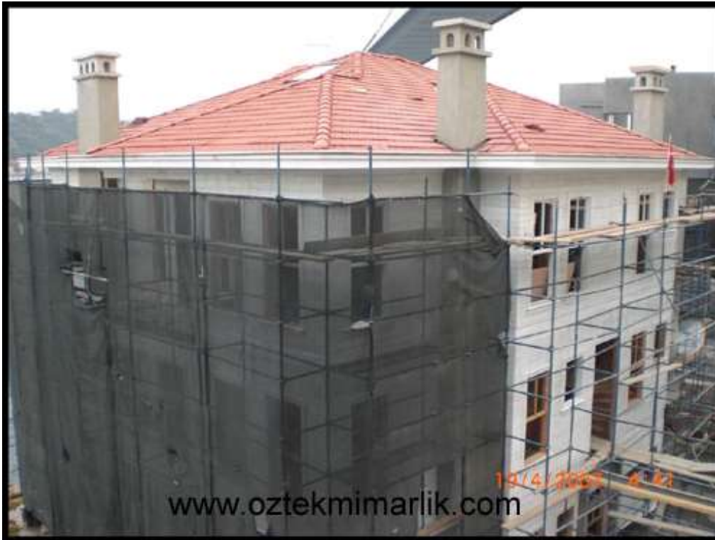
Binanın genel durumu 4
