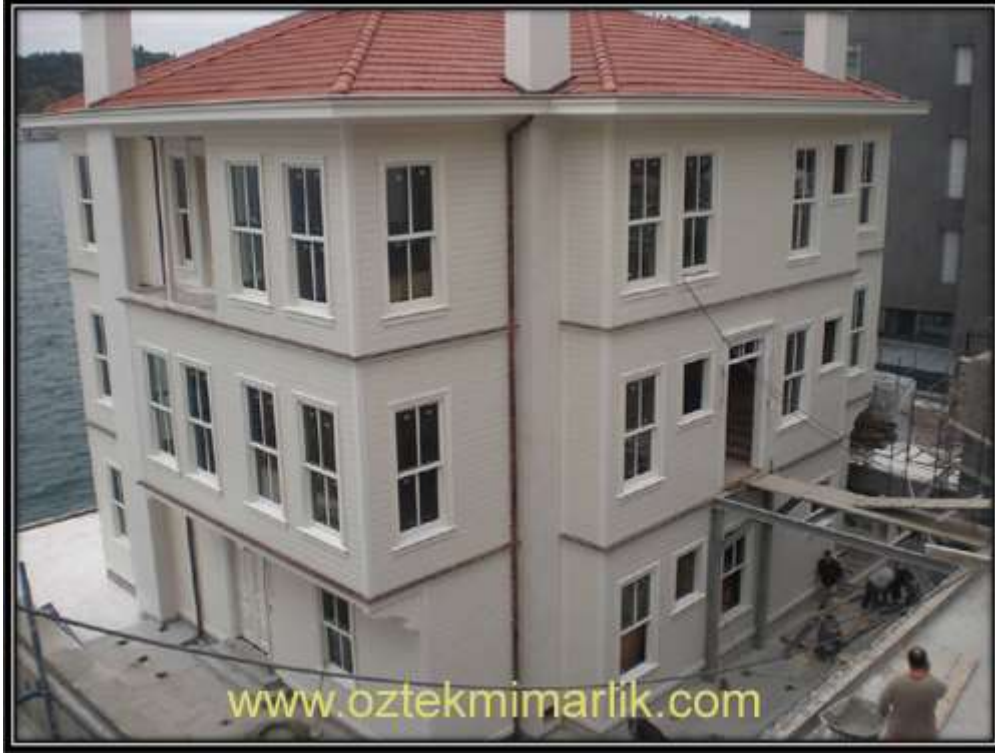
Binanın genel durumu 6
