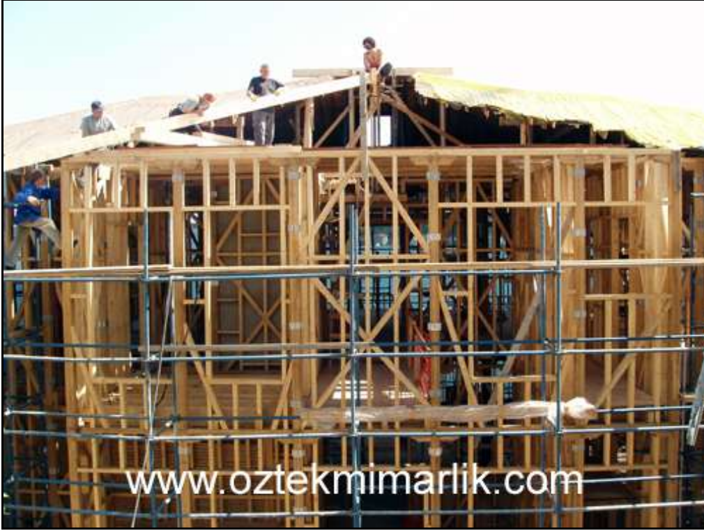
Yeni kurulmuş çatı konstrüksiyonu. Konstrüksiyonun üzeri su-kontrası ile kaplanıyor.
