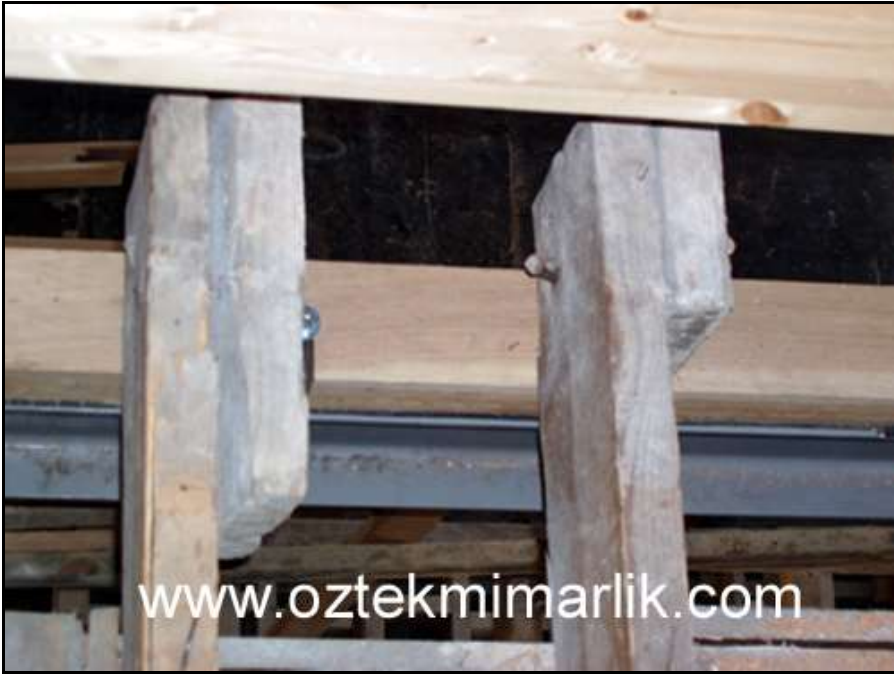
Bu fotoğrafta aynı yastığa oturan iki ayrı odanın kirişleri görülüyor. (üstten bakış)
