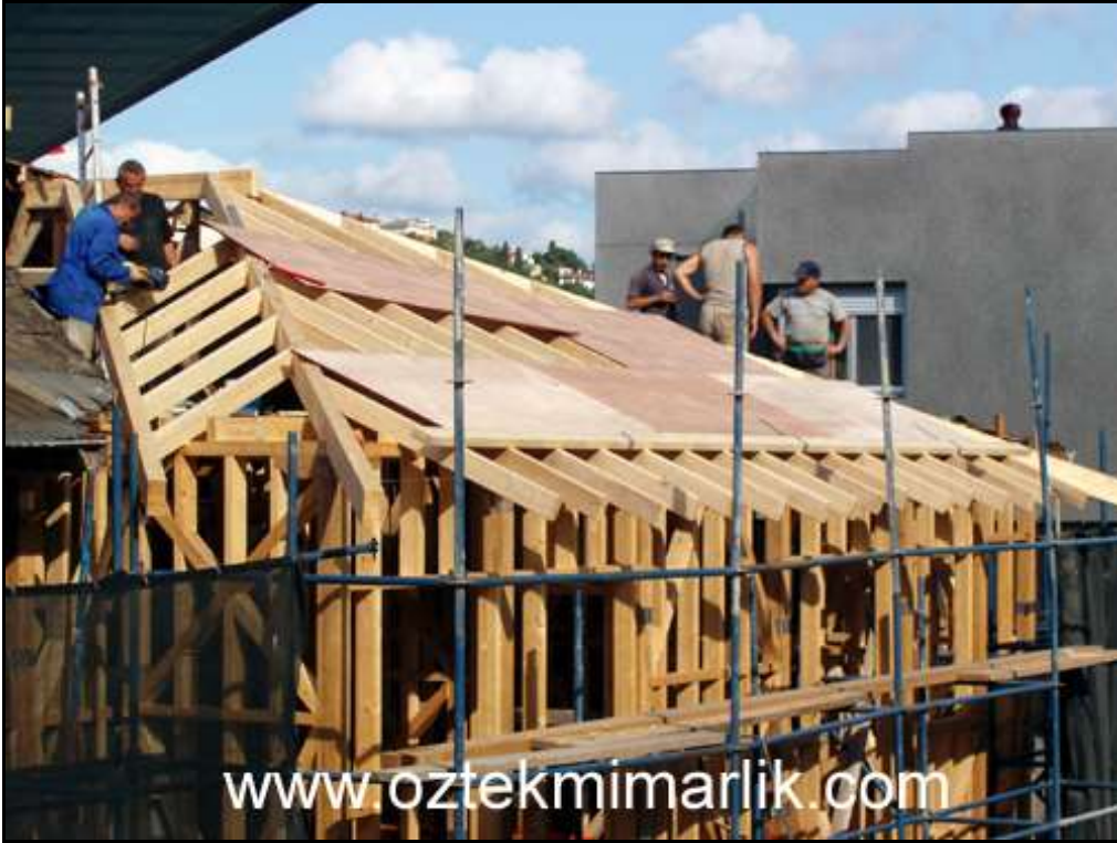
Yeni kurulmuş çatı konstrüksiyonu. Konstrüksiyonun üzeri su-kontrası ile kaplanıyor.
