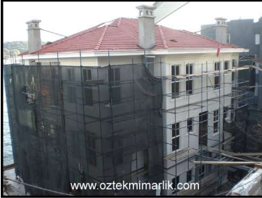
Binanın genel durumu 5
