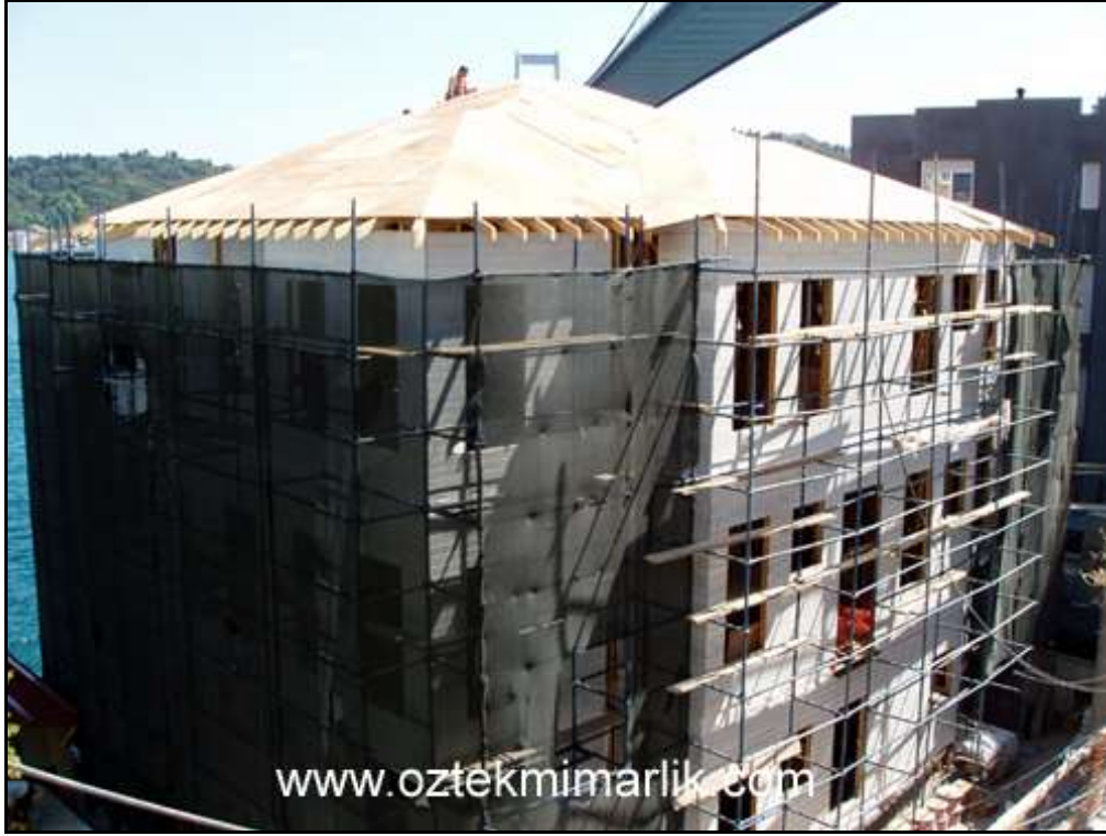
Binanın genel durumu 3
