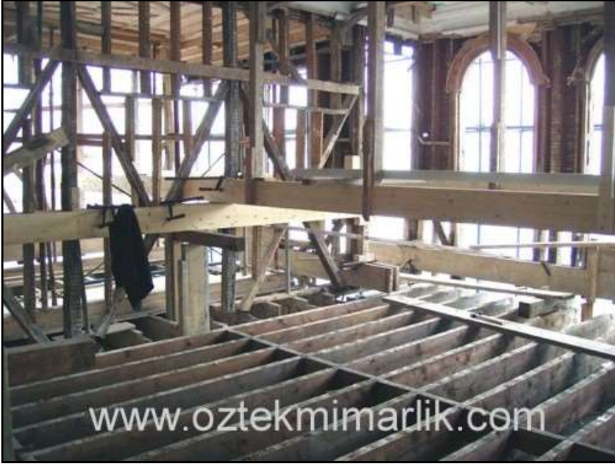
Bu fotoğrafta aynı yastığa oturan iki ayrı odanın kirişleri görülüyor. (üstten bakış)
